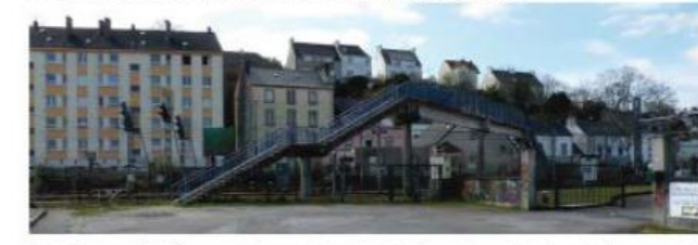
▲ 4. Passerelle piétonne au dessus des voies ferrées et façade le long de l'avenue de la Libération
