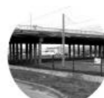
Pont routier 2x2 voies
