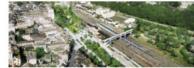
▲ 2. Passerelle piétonne du projet de requalification de la gare
