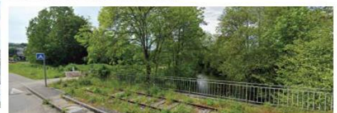
▲ 5. Pont routier de la rue Kerhuel
